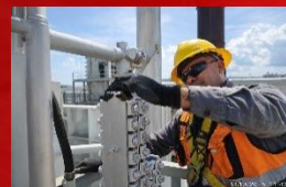
Instalación en campo
